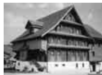
Wohnhaussanierung, Rothenthurm SZ
