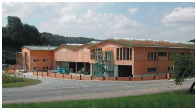
L'OCA a réalisé le Centre Energie-bois du Nord-ouest de la Suisse, dont le volume bâti s'élève à 31 500 m<sup>3</sup>. Des chablis de Lothar ont servis à la construction du gros-œuvre, des plafonds, du toit, des façades et à l'aménagement intérieur. Le toit couvert de végétation protège contre la chaleur et sert de réserve d'eau de pluie. Le bâtiment est chauffé à l'aide de plaquettes de bois.
