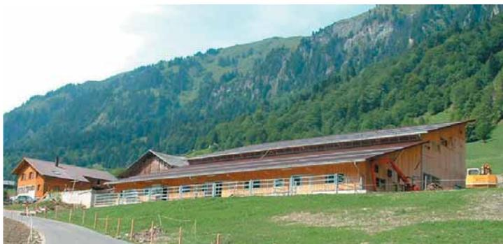
Exemple d'étables et de ruraux à Klöntal GL. L'OCA offre un système de construction modulaire, qui peut être adapté à l'évolution des besoins en cas de reconversion de l'exploitation.
