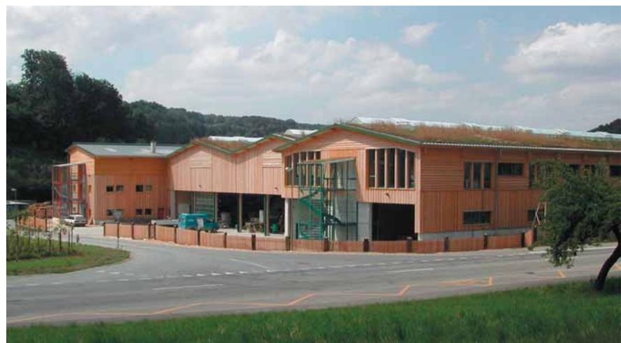
Il Centro per la produzione di energia dal legno realizzato dall'UCA nella Svizzera nord-occidentale con un volume complessivo di 31 500 m<sup>3</sup>. Per la costruzione, i soffitti, il tetto, le facciate e le finiture interne è stato utilizzato il legno proveniente dalle piante abbattute dalla tempesta Lothar. La costruzione del tetto a verde svolge la funzione di protezione termica e di riserva d'acqua piovana. L'edificio è riscaldato con una caldaia a trucioli di legno.
