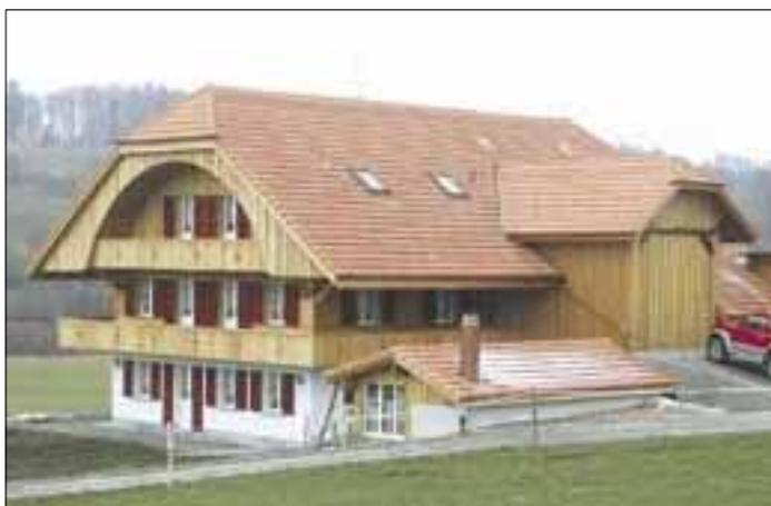
Ferme à Uetendorf BE. La partie habitable de la ferme était en très mauvais état. C'est pourquoi tout a été démoli, jusqu'à la charpente du toit qui a été conservée, et remonté avec remise à neuf dans la forme originelle. La planification a été confiée à LBA Heiligenschwendi, en étroite collaboration avec les services de la protection du patrimoine du canton de Berne.
