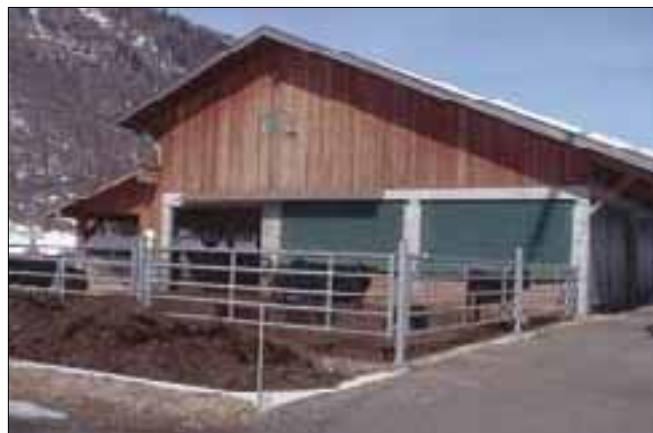
Nuova costruzione ecologica per una mandria di vacche fattrici di razza Galoway a Obergesteln VS. Anno di costruzione: 1997, progettazione: UCA di Visp.
