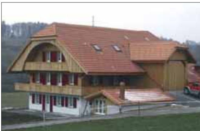
Casa contadina a Uetendorf BE. La parte abitativa era in pessime condizioni. È stata perciò demolita fino all'ossatura del tetto, che è stata conservata, e ricostruita ripristinando le condizioni originali. La progettazione è stata effettuata dall'UCA di Heiligenschwendi in stretta collaborazione con l'Ufficio dei monumenti storici del Canton Berna.
