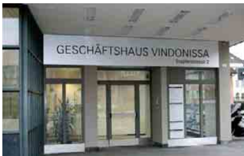
Nach umfassender Sanierung unter der Leitung des LBA Brugg konnte Treuhand & Schätzungen neue Büroräumlichkeiten im Geschäftshaus Vindonissa beziehen. Der Eigentümer des Gebäudes ist die Krankenkasse Agrisano.
