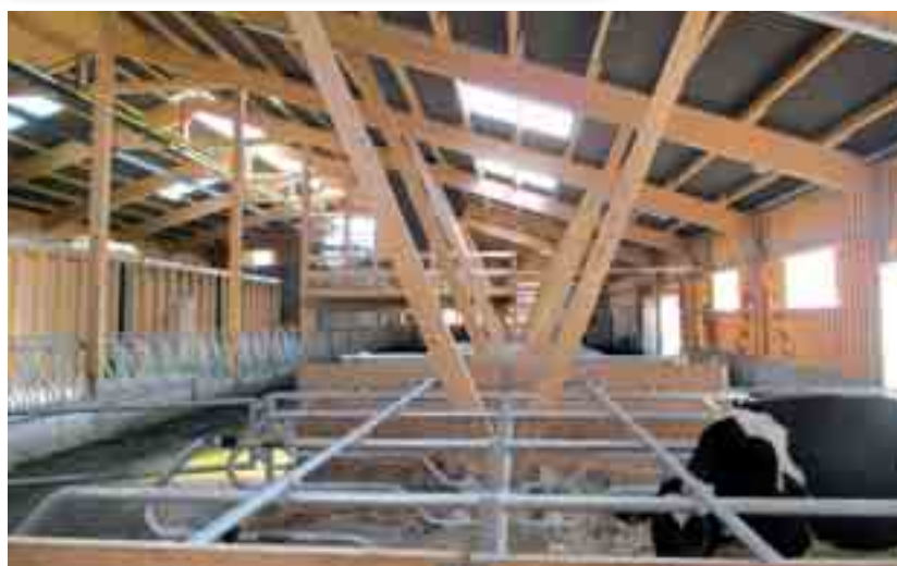
Das LBA Ostschweiz plante und realisierte dieses neue Ökonomiegebäude für 50 Milchkühe mit effizienten Arbeitsabläufen und ausgezeichnetem Tierkomfort.
