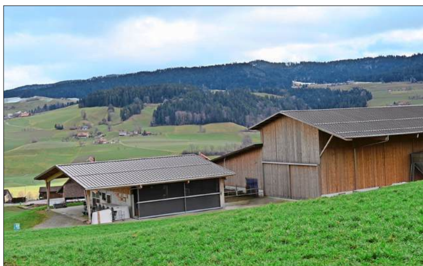
Der Hof der Familie Brechbühl liegt oberhalb des Konolfinger Dorfkerns. Das Wohnhaus mit dem alten Stall liegt noch etwas weiter oben.
